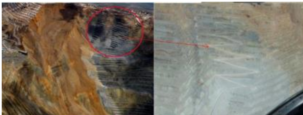
Рисунок 1. Деформация борта полиметаллического карьера [3]
