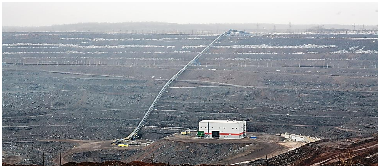
Рисунок 1. Крутонаклонный дробильно-конвейерного комплекса (ДКК-1)
