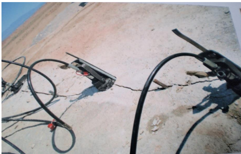
Рисунок 4. Образование направленной трещины гидроклиньями СЭГР в скальном массиве на карьере блочного камня
